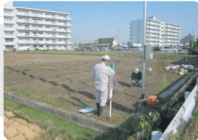
02 測量基礎位置 Surveying
