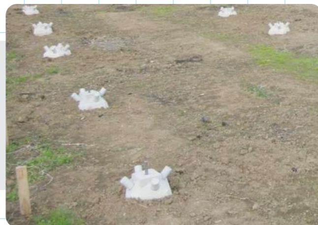
05 基礎設置完成 Completion of Foundations
