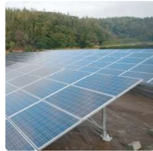
安裝角度20° Mounting angle: 20°
