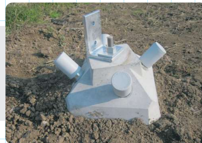
06 安裝柱腳零件 Installing Brackets
